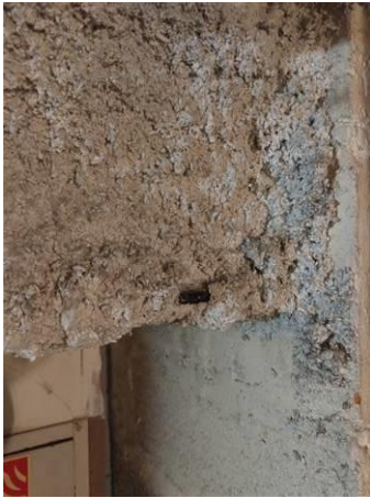
Photo n° PhA003 Localisation : BATIMENT A - ZDa02PI SOUS SOL Ouvrage : Flocages, Calorifugeages, Faux plafonds Partie d'ouvrage : Flocages Description : Flocages Localisation sur croquis : P3
